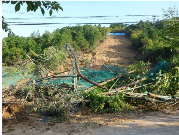
下から見る崩壊の状況
