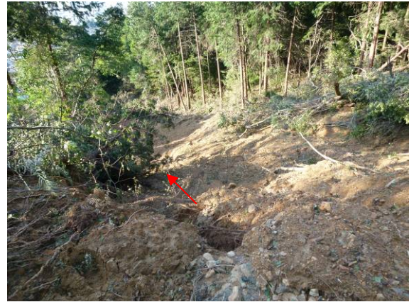
崩壊の下流側
