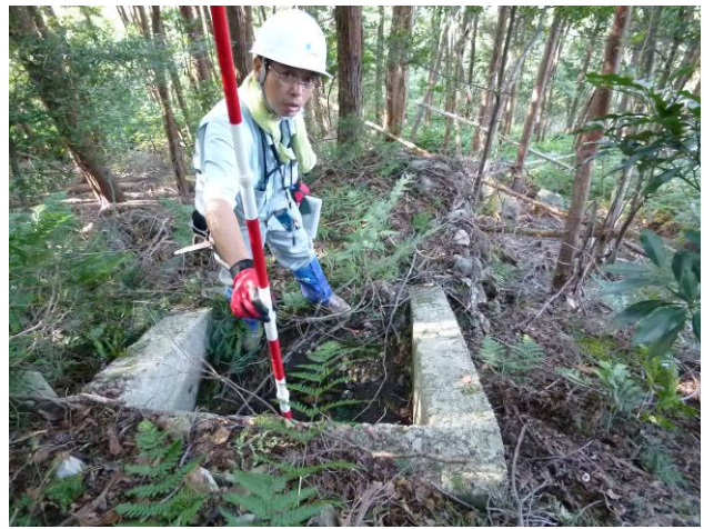
道路排水施設
