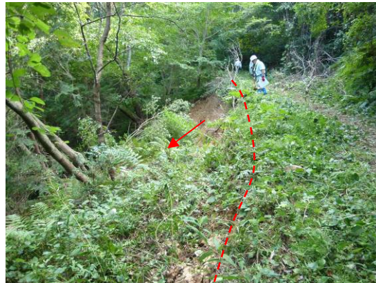
谷側の崩壊地と亀裂
