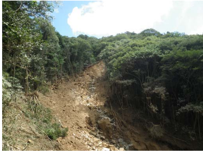
写真 1 4 崩壊地の状況
