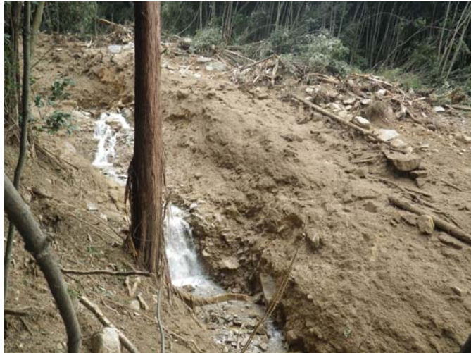
写真8 宅地直上流部の流路の表層土流出状況
