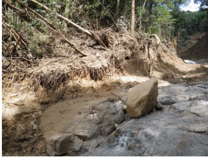
写真 1 3 溪岸の残存土塊の状況
