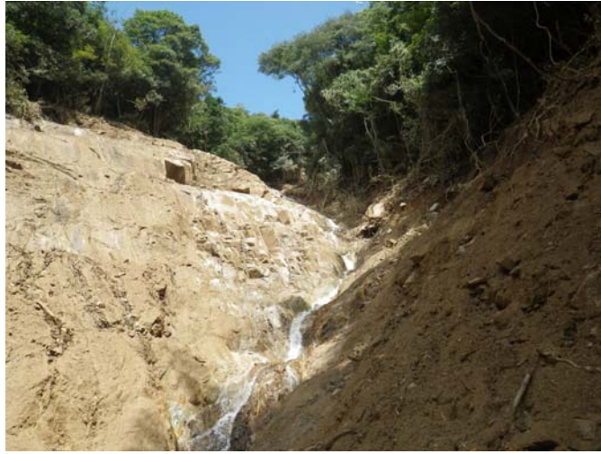
写真16 上流部流路の状況
