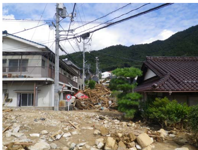
写真3 道路への流木堆積状況
