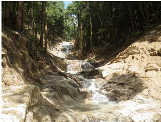
写真 1 2 溪床土砂の流出状況
