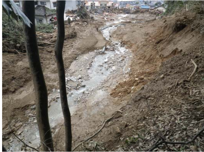
写真7 宅地上流側の流路付近の堆積状況
