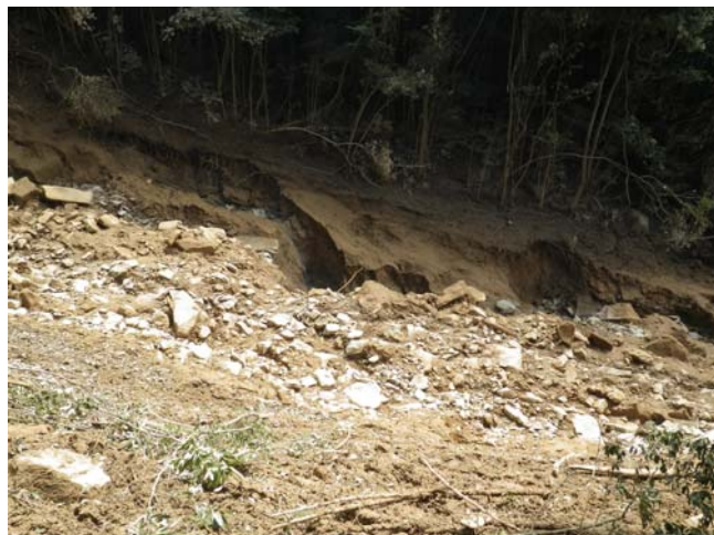
写真 1 5 崩壊地脚部の土砂残存状況
