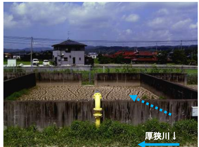
写真6 水没した浄水場
