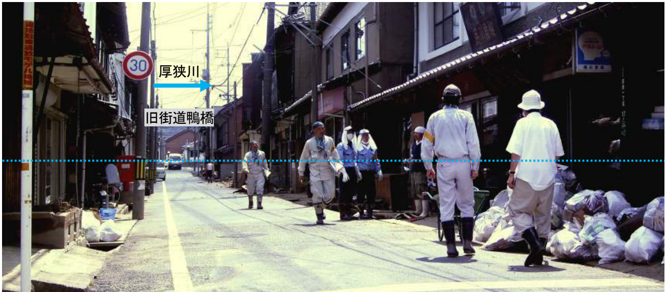
写真9 排水路東側商店街（水色点線：浸水痕跡 約1.2m）
