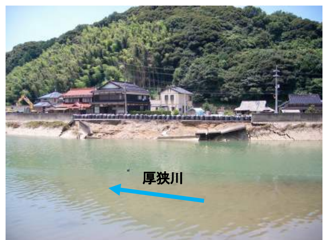
写真11 下流右岸特殊堤決壊箇所
