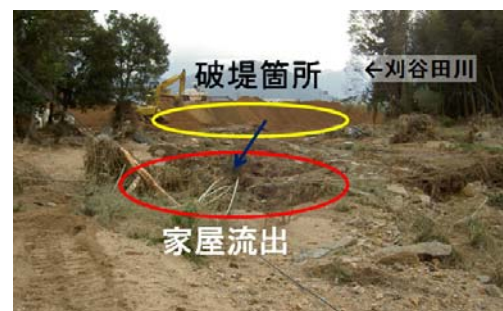
写真 1 H16.7 新潟豪雨 刈谷田川破堤箇所近傍の家屋流出状況
