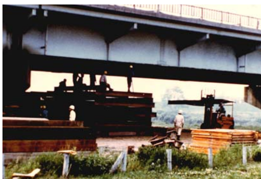
橋梁の応急復旧（’78 宮城県沖地震）
