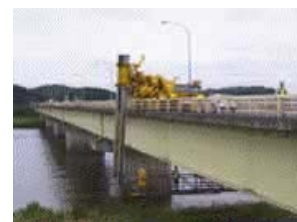
橋梁点検車の稼働 (’03 宮城県北部地震)
