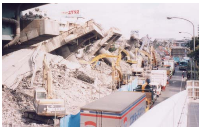
橋脚の斫り作業（'95 兵庫県南部地震）
