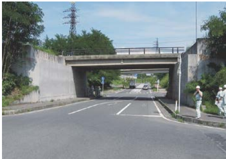
写真-1 第二丸山跨道橋（現在）
