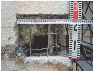
写真-4 はつり調査による鉄筋の状態の確認
