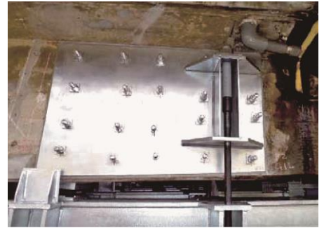
写真-3 ヒンジ部補強完了状況
