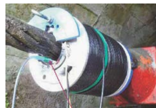
写真-3 全磁束法による腐食状況調査
