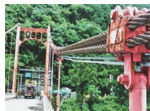
写真-4 セーフティケーブル設置状況
