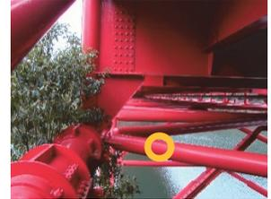
写真-5 耐震補強部材
