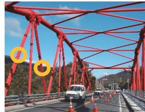
写真-4 制震ダンパー(斜材)
