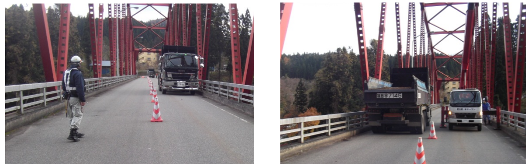
ダンプトラックの通過状況
