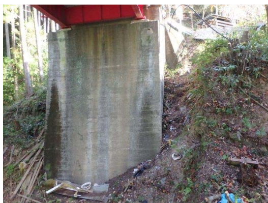
A1 橋台側斜面
