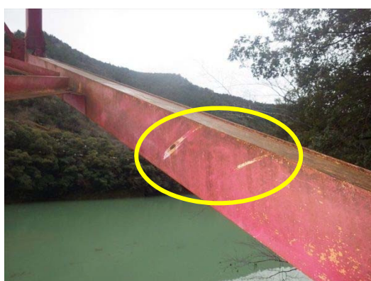
漂流物衝突痕(アーチリブ接触痕)
