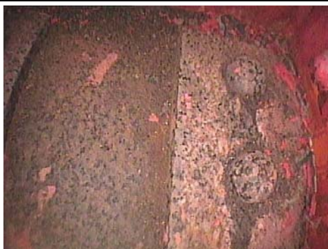
No. 24-25間(上流側) ⑤下面 局所的な腐食膨張
