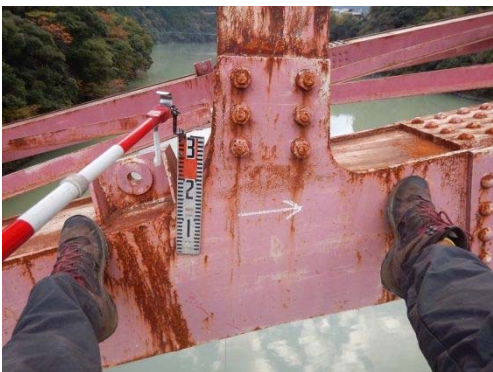
アーチリブと支柱の接合部
