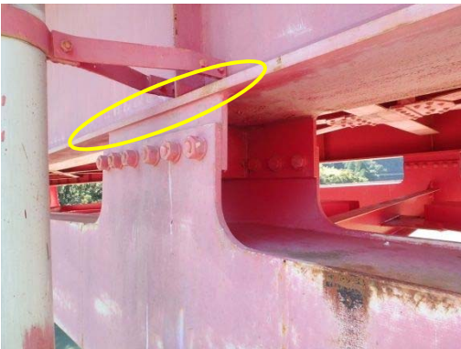
(補剛桁付きガセットの溶接部)
