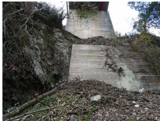
A2 橋台側斜面
