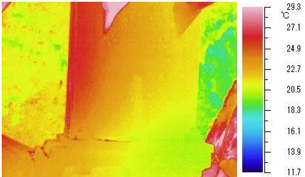
図-7 起点下流側柱
