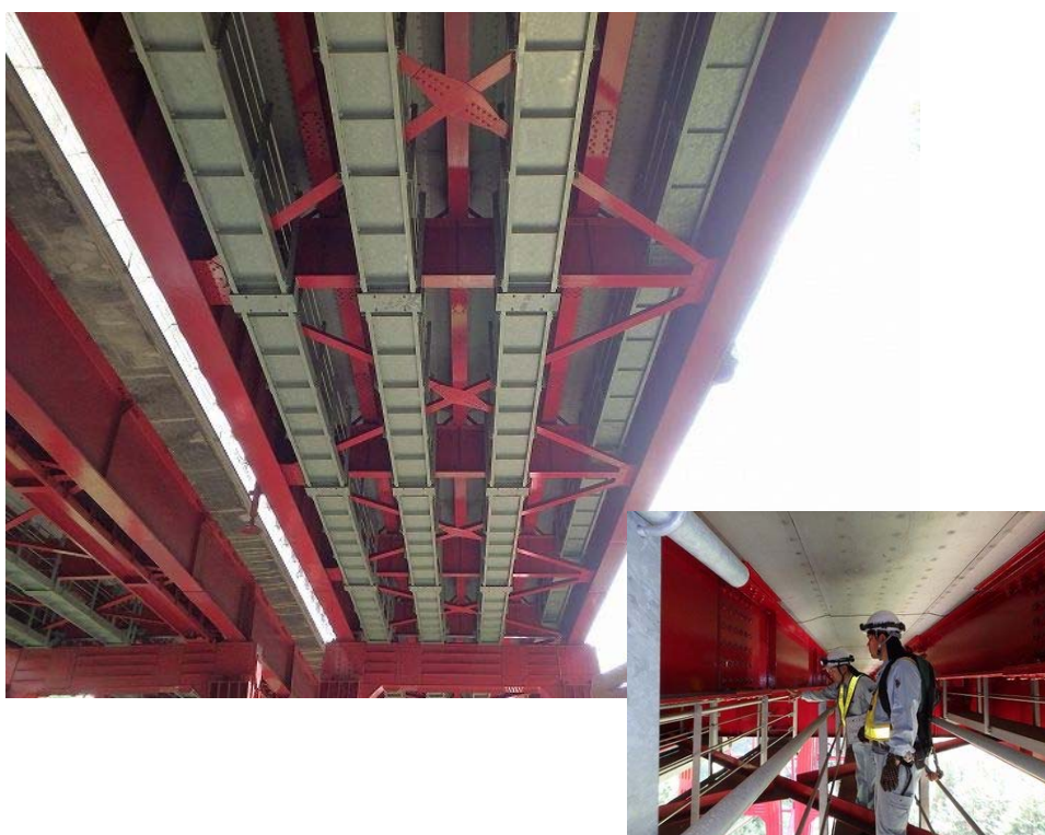
①補剛桁床版下桁間検査路の事例
