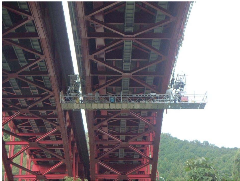
参考 アーチリブ点検方法の事例（仮設移動式足場）
