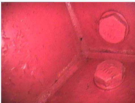
No. 25-26間(上流側) ⑤下面 局部的に腐食膨張
