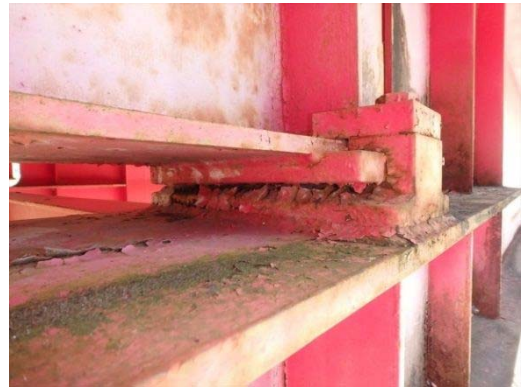
(ランガー補剛桁側)
