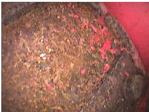
No. 25-26間(上流側) ⑤下面 局部的に腐食膨張
