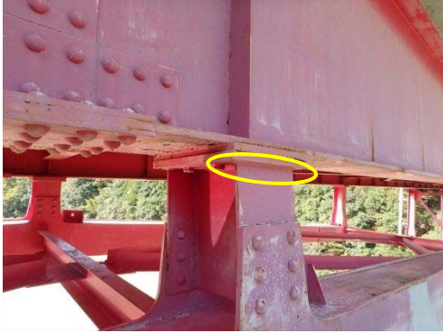
(接合プレートとガセットの溶接部)
