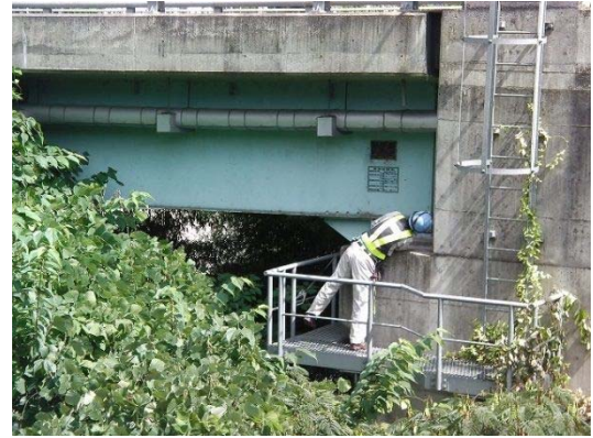
梯子および橋台前検査路の事例
