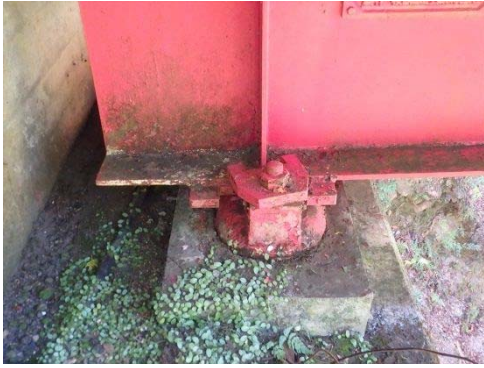
橋台側桁端部
