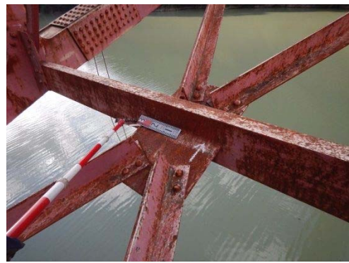
アーチ横構の接合部
