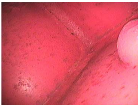
No. 24-25間(上流側) ⑤下面 局所的な腐食膨張
