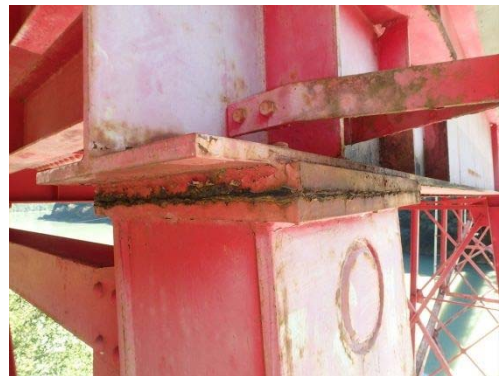
補剛桁と支柱の接合部
