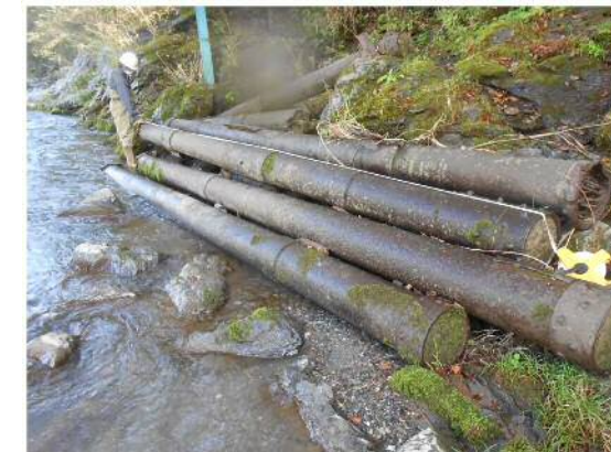
下流側鋼管放置状況 (P3、P4 竣工時躯体)
