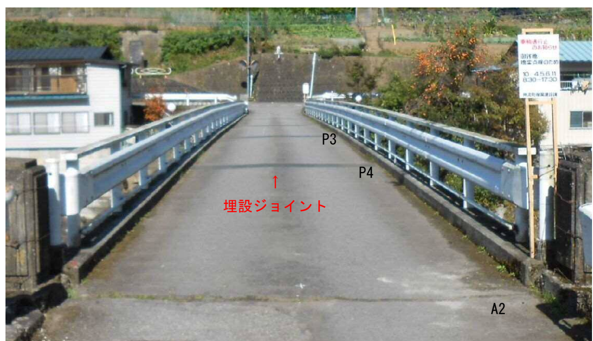
伸縮装置図（埋設ジョイント）
