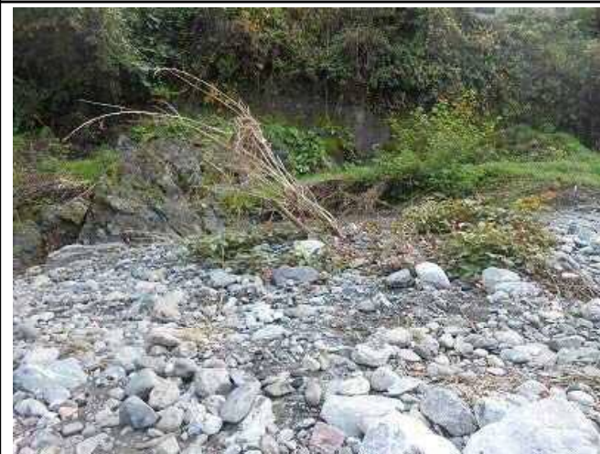
上流10m 右岸側
