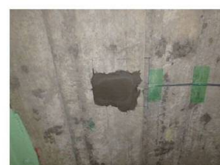
44-無収縮モルタル補修
