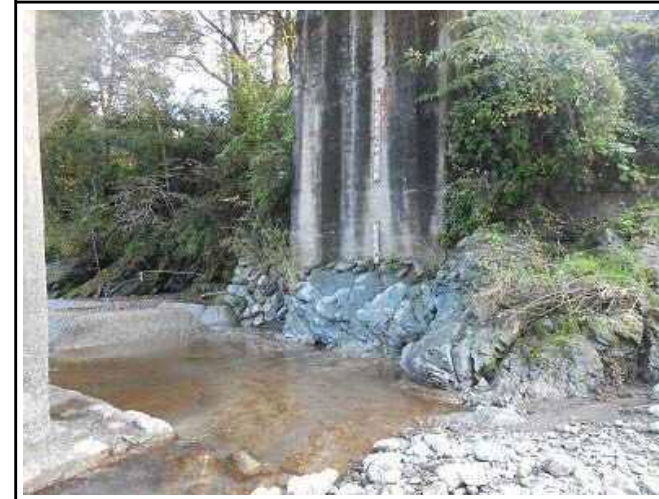
御鉾橋(0m) 左岸側
