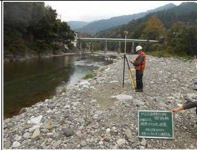
横断方向杭設置
