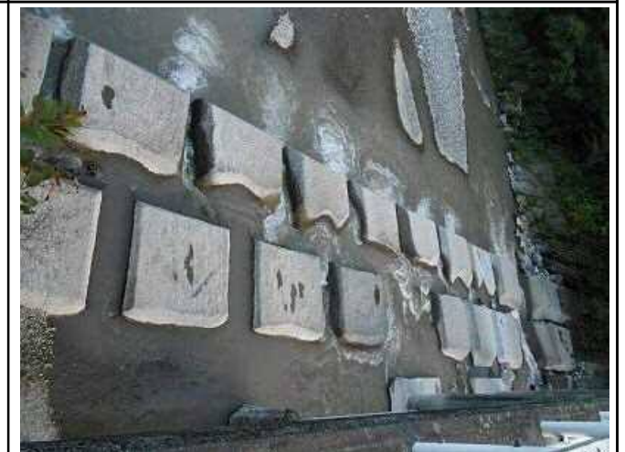
コンクリート堰
