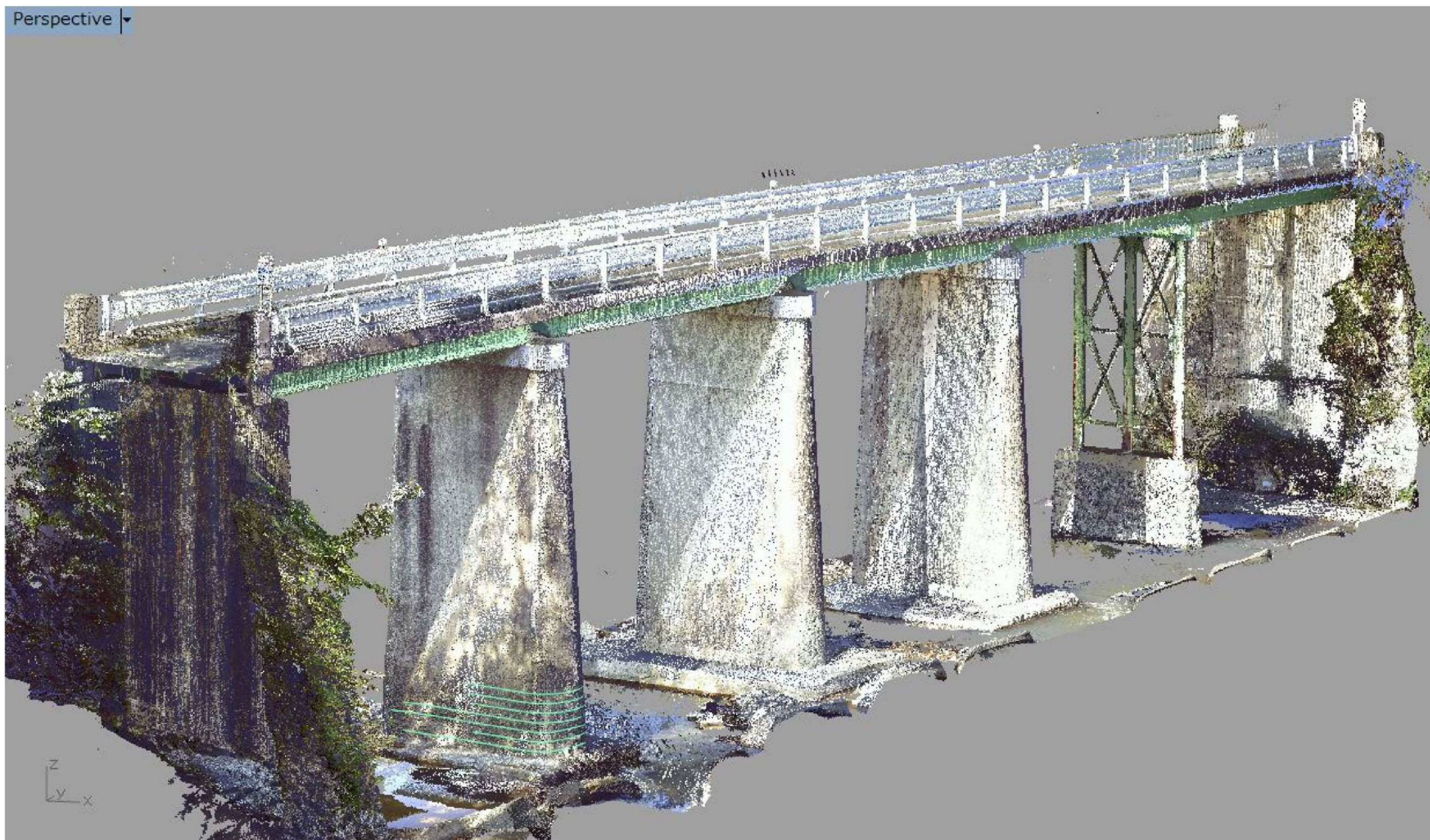
b) 移動・傾斜の計測 (3D スキャン)
