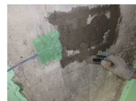
42-無収縮モルタル補修
