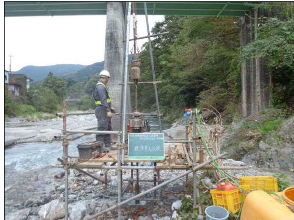
図 2.5 標準貫入試験実施状況
