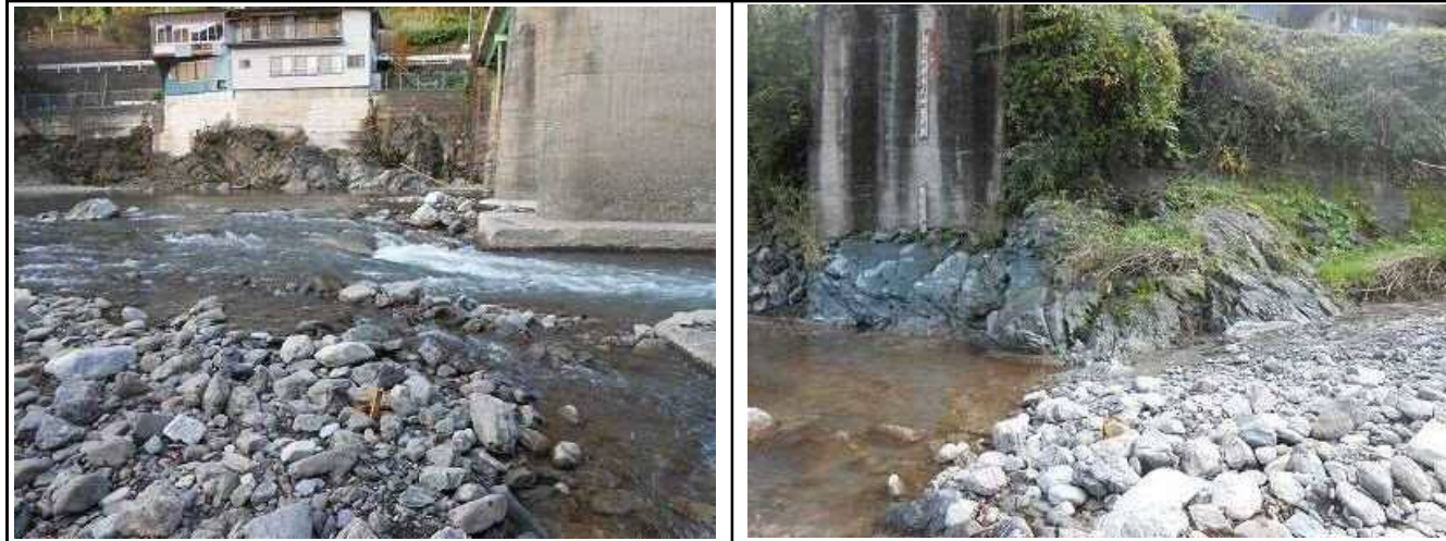
上流5m 左岸側
