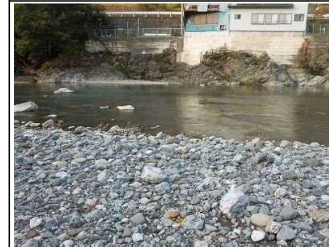
上流25m 左岸側
