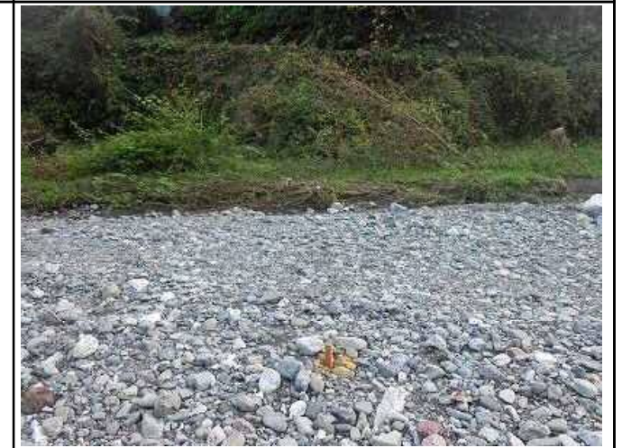
上流30m 右岸側
