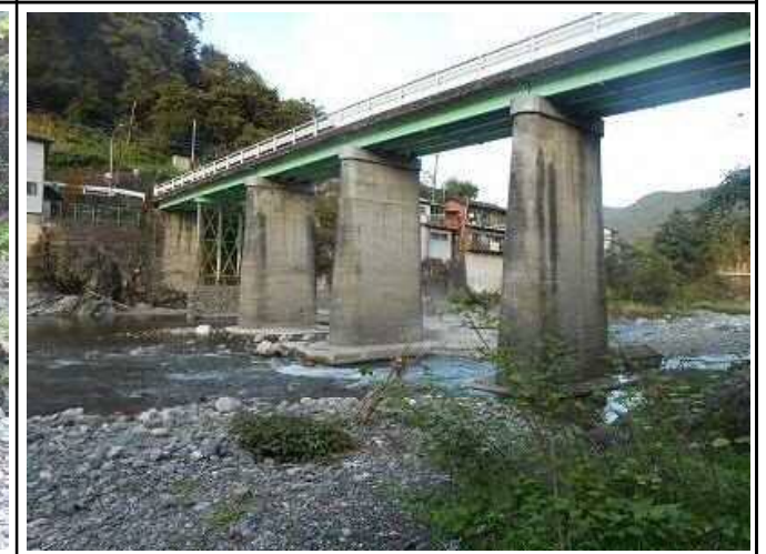
御鉾橋(0m) 全景
