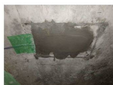
43-無収縮モルタル補修
