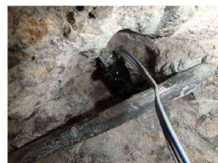
37-床版配力筋防湿:SBテープ&VMテープ
