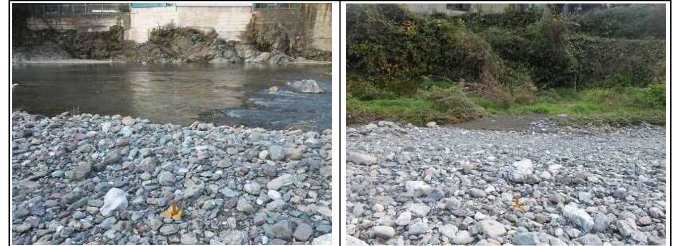
上流20m 左岸側
