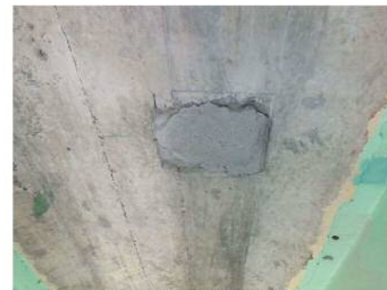
64-無収縮モルタル補修
