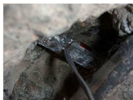
36-床版配力筋ゲージ貼付
