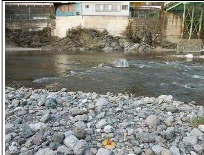
上流15m 左岸側
