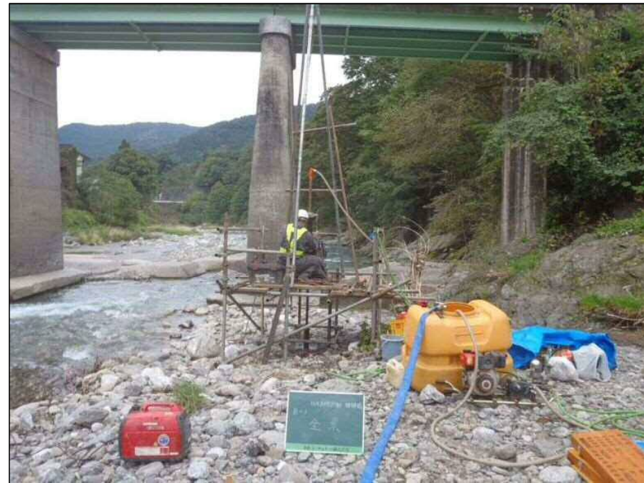
図 2.2 ボーリング作業状況
