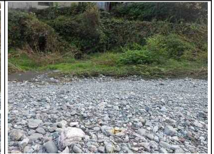
上流25m 右岸側
