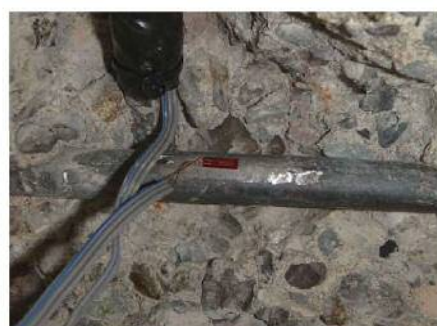
35-床版主鉄筋ゲージ貼付
