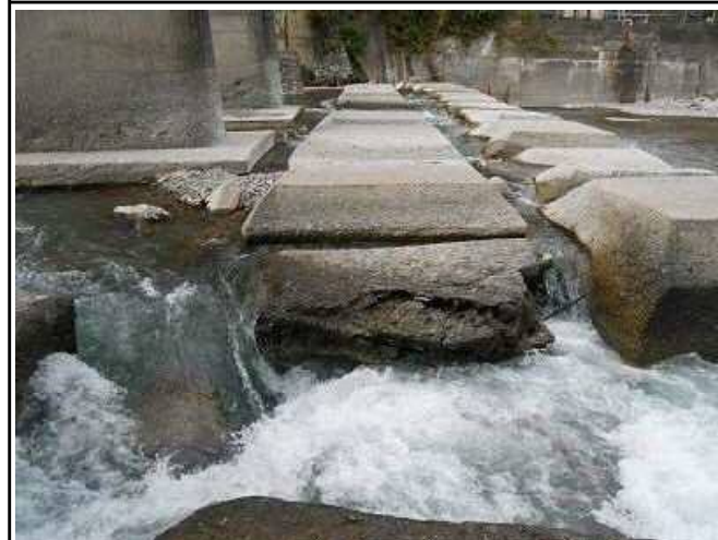
コンクリート堰
