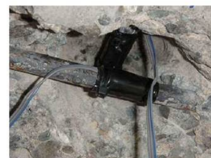
38-床板主鉄筋防湿:SBテープ&VMテープ
