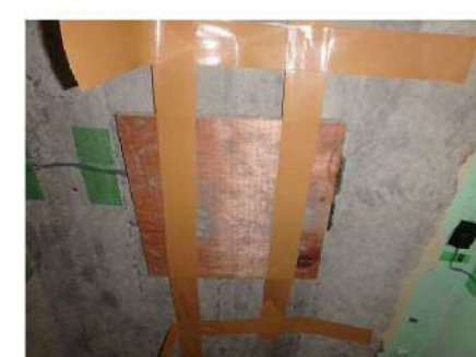
45-無収縮モルタル補修
