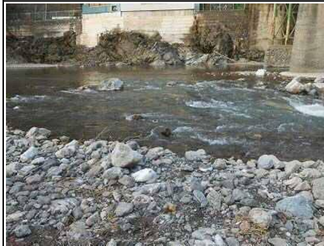
上流10m 左岸側
