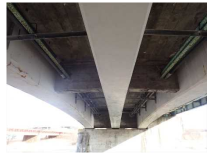
6 径間目 PCT 桁
