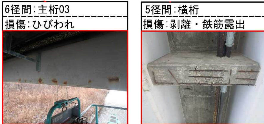
写真 5.2 主桁・横桁の損傷状況写真
