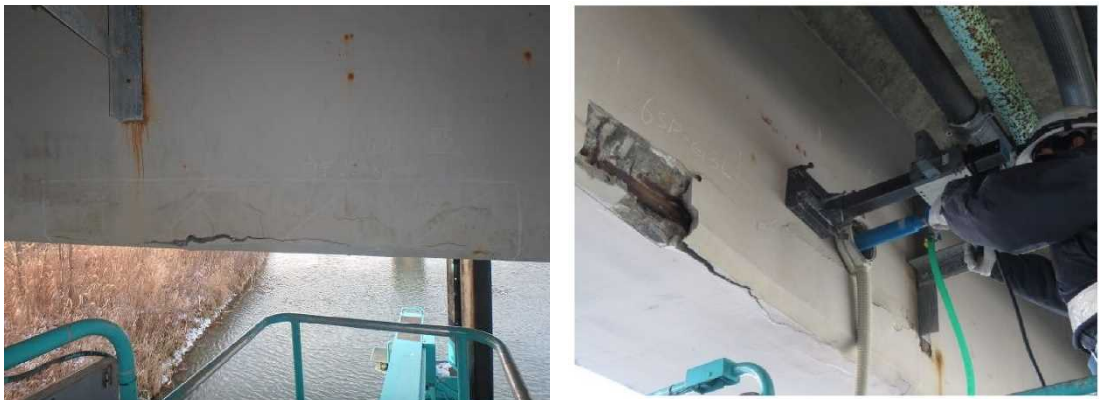
図 5.1 主桁の試料採取 (□ 枠 6sp-G3-1)
