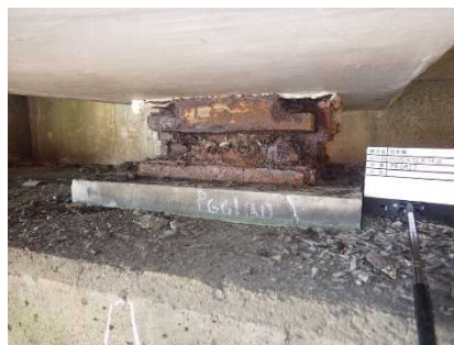
P6 起点側支承
