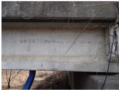
7 径間目 PCT 桁
