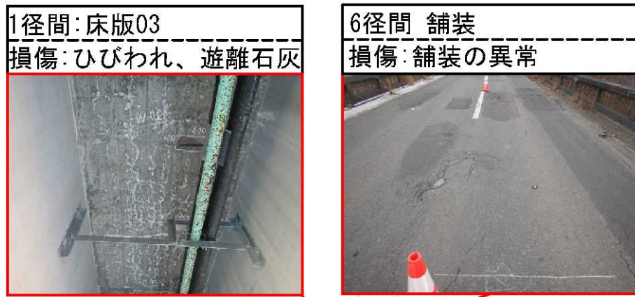
写真 5.4 床版・舗装の損傷状況写真
