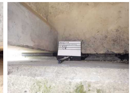
A2 橋台支承
