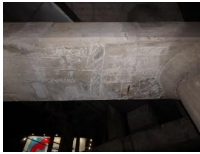
P 1 橋脚（中間梁部）
