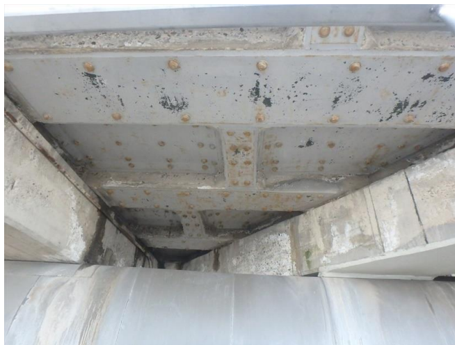
写真 2.1.2 旧車道部桁下(第10径間)
