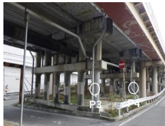
全景写真(桁下)
