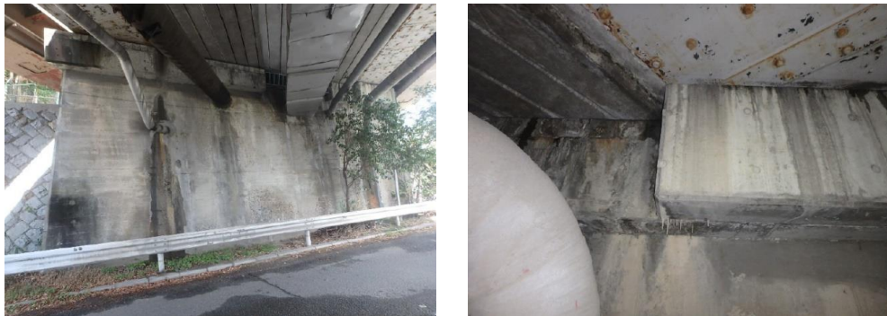
写真 2.2.1 A1 橋台縁端拡幅
