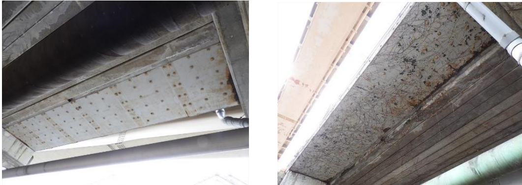
写真 2.1.3 旧歩道部桁下(第7径間)左：上り線、右：下り線
