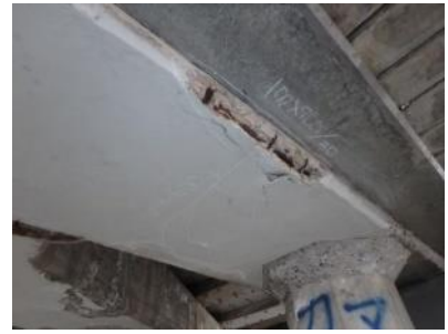
P 9 橋脚（枕梁部）
