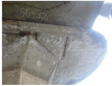
P 7 橋脚（枕梁部）
