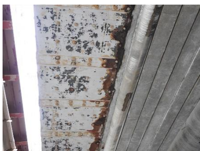
第1径間（上り車線側）
