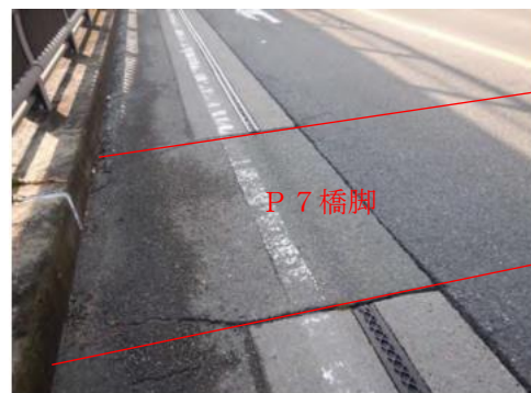
写真 2.1.6 縦目地 (第7橋脚上)
