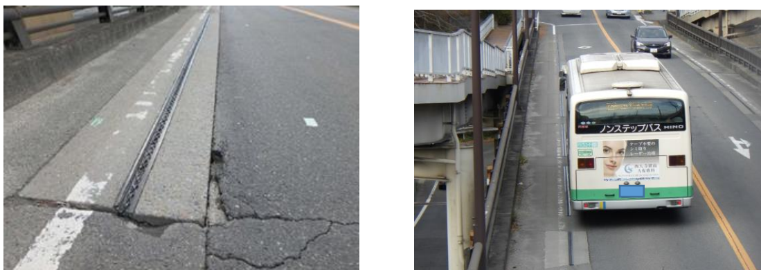
写真 4.1.8 縦目地と車両の通行状況
