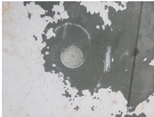
写真 2.1.4 接着樹脂の状況(健全部削孔箇所)
