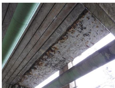
第6径間（下り車線側）
