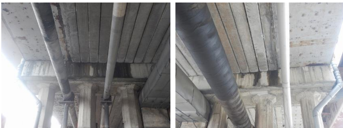
写真 2.1.1 旧車道部桁下(第3径間)
