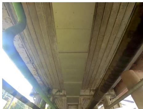
写真 4.1.3 主桁下面の状況 (第5径間)
