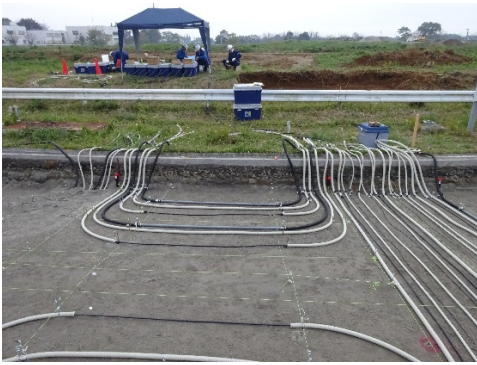
ケーブル敷設(通信)
