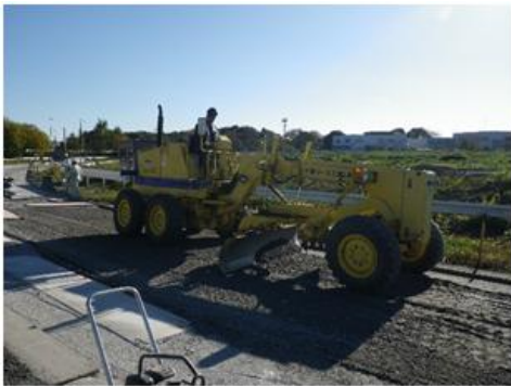
上層路盤の敷設(敷均し)
