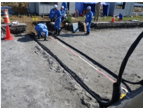
ケーブル敷設(電力)
