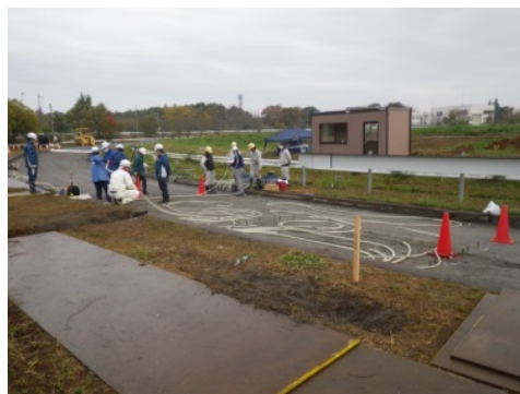
ケーブル敷設(通信)
