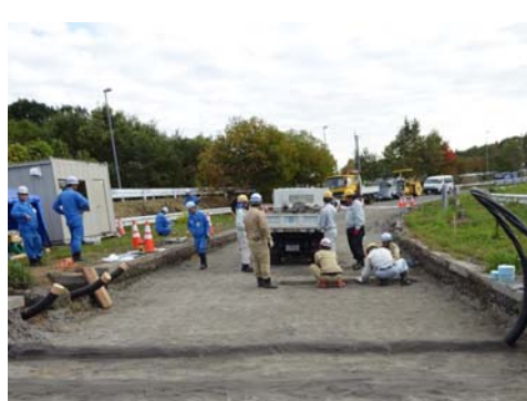
ケーブル敷設(電力)
