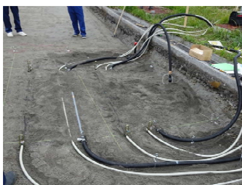
ケーブル敷設(通信)
