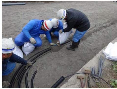
ケーブル敷設(ケーブルテレビ)
