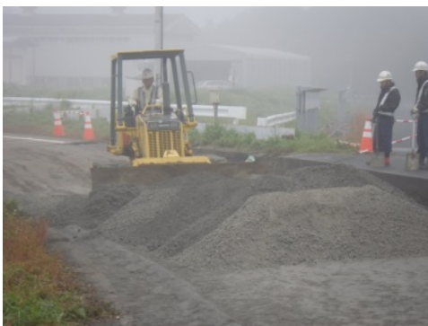
下層路盤の構築
