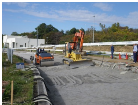
ローラーにより転圧
