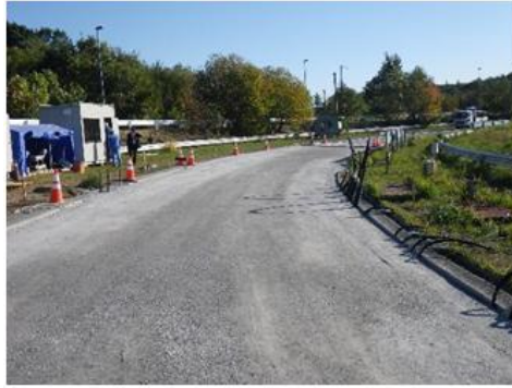
転圧後の状況
