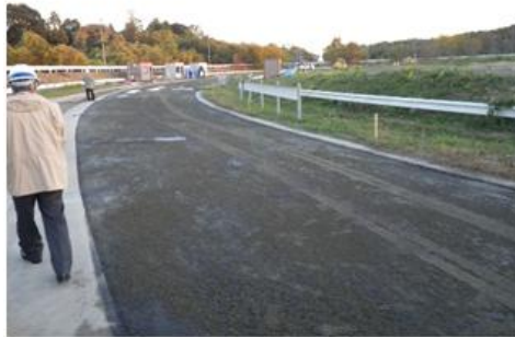
アスファルト乳剤散布後の状況
