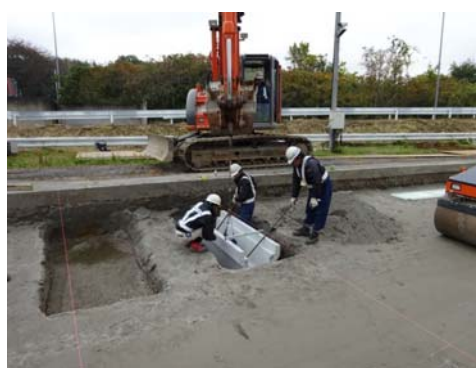
小型ボックス敷設
