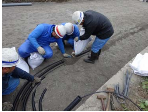
ケーブル敷設(ケーブルテレビ)
