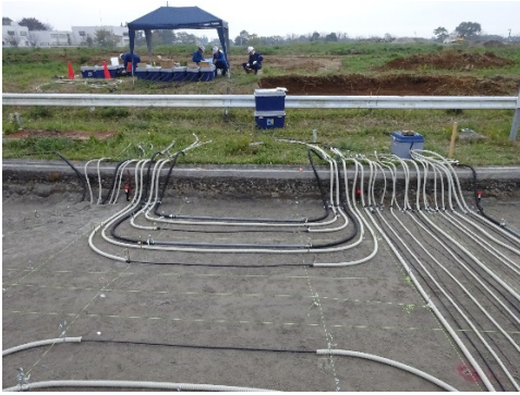
ケーブル敷設(通信)
