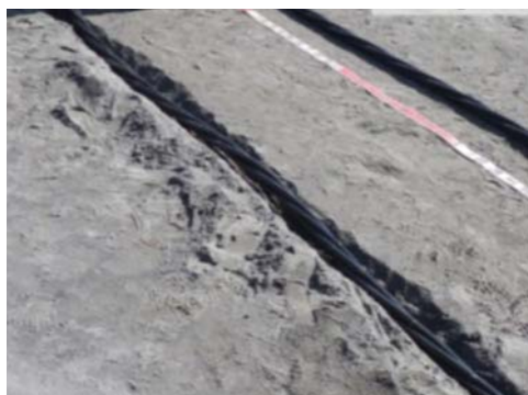
ケーブル敷設(電力)
