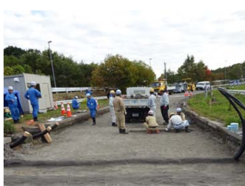
ケーブル敷設(電力)
