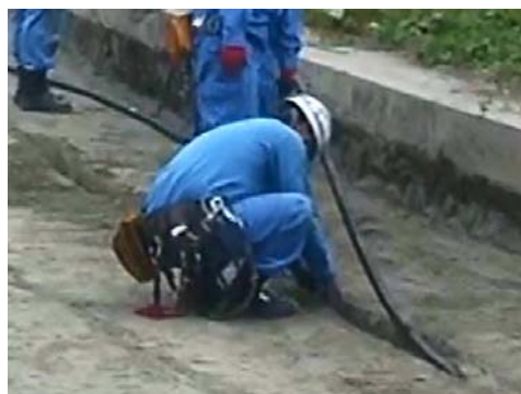
ケーブル敷設(ケーブルテレビ)
