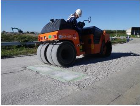
上層路盤の敷設状況
