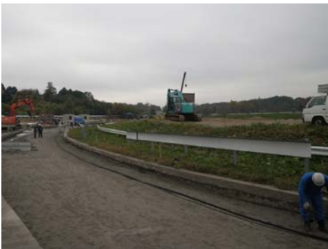
ケーブル敷設(ケーブルテレビ)
