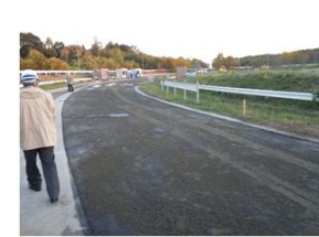
アスファルト乳剤散布後の状況
