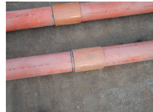
掘り起こした高圧管
