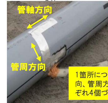
【ひずみゲージの設置状況】
