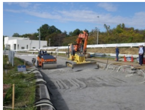
ローラーにより転圧
