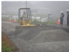
下層路盤の構築
