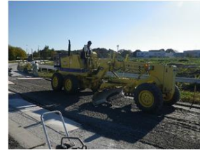
上層路盤の敷設(敷均し)
