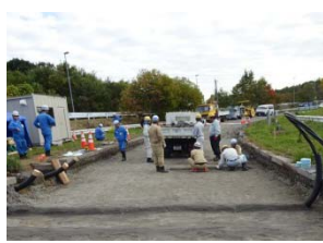
ケーブル敷設(電力)
