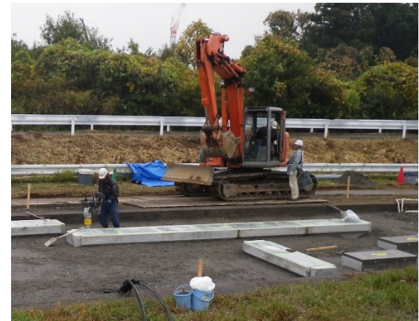
ボックス周辺をランマーで締め
