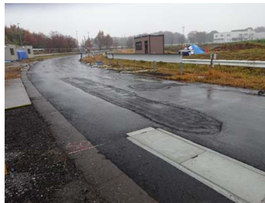
◀ 補修後の状況
