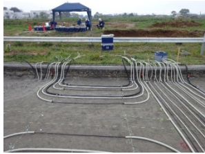
ケーブル敷設(通信)
