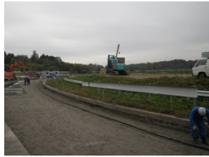
ケーブル敷設(ケーブルテレビ)
