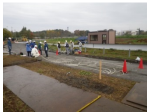
ケーブル敷設(通信)
