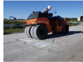
上層路盤の敷設状況
