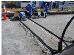
ケーブル敷設(電力)
