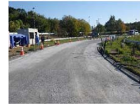
転圧後の状況
