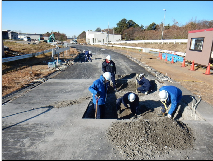
《掘削作業の状況》
