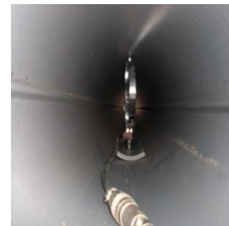
【変位計の設置状況】
