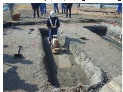
転圧状況【プレート】
