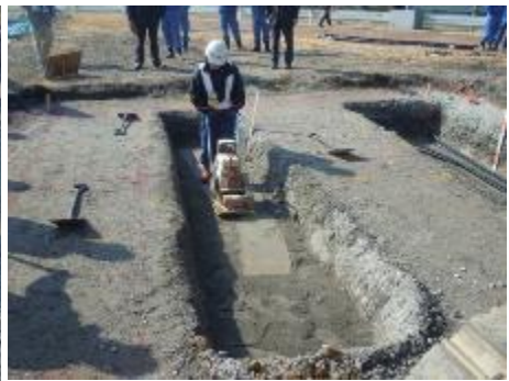
転圧状況【プレート】
