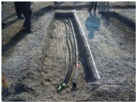
ケーブル敷設【砂巻】
