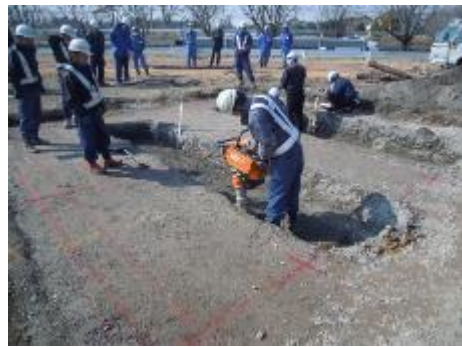
転圧状況【ランマー】
