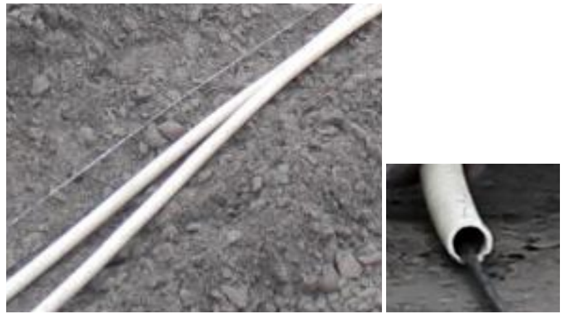
保護管によるケーブルの保護の例
