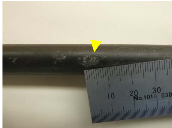
【損傷】 傷の大きさ（長さ）7 mm
