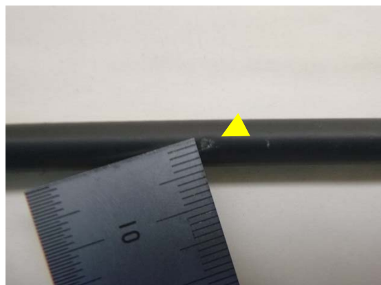
【損傷】 傷の大きさ（長さ）3mm
