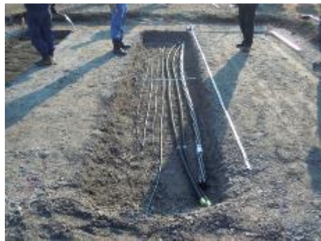
ケーブル敷設【碎石】
