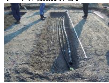
施工の様子 ケーブル敷設【碎石】
