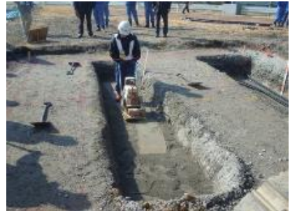
転圧状況【プレート】
