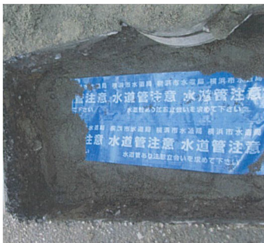
埋設シートの敷設状況
