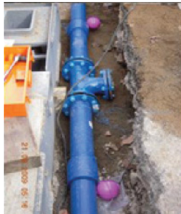
ICタグにより路面から埋設物を探査する機器の例(英国の例)
